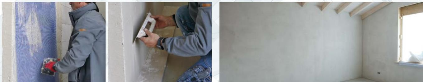
**CONSUMO** Per realizzare 1 m<sup>3</sup> di muratura in GASBETON® servono circa 25 kg di collante se il blocco è liscio quindi per ogni bancale di blocchi da 1,08 m<sup>3</sup> occorre considerare circa 27 kg di malta. Se utilizzato come rasante si consideri un consumo pari a circa 1,3 kg/m<sup>2</sup> per mm di spessore.
